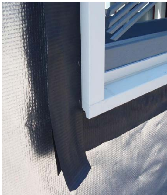
Figur 10 Utfackningselement med aluminiumklädd duk kompletterad med tätningar kring fönster
