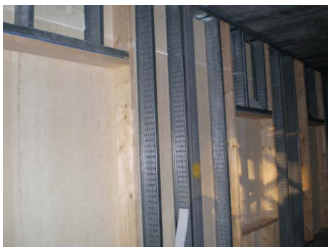
Figur 1. Utfackningsvägg med plåtreglar och träreglar som byggs på plats med utvändig skiva typ Glasroc som monterats kontinuerligt över bjälklagsgränserna och utan håltagning för fönster för att snabbt erhålla ett tåligt väderskydd.
