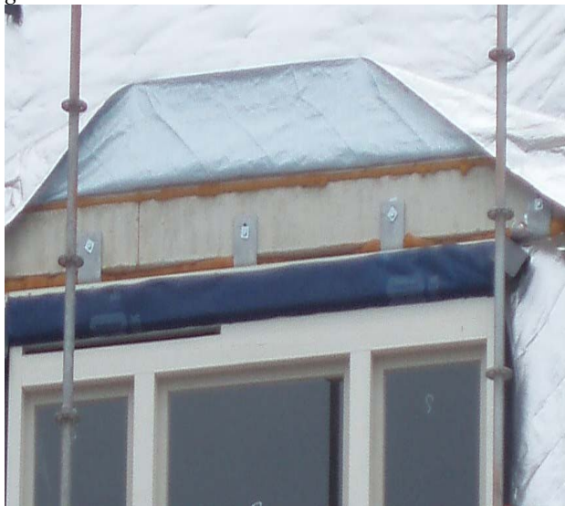
Figur 6 Infästning av utfackningsvägg till överkant bjälklag
