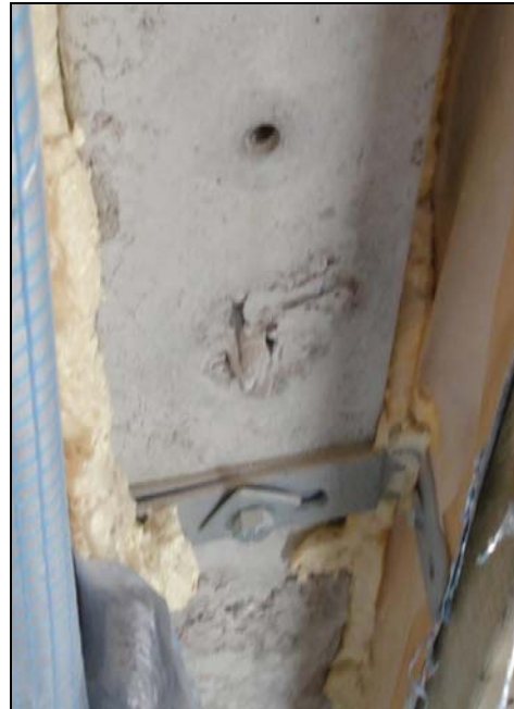
Figur 5 Infästning av utfackningsvägg mot betongvägg
