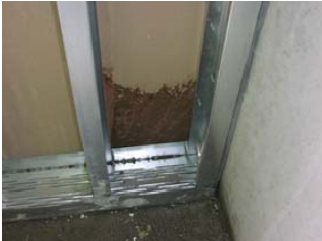
Figur 14. Utvändigt gipsskiva har fuktats upp och missfärgats av regnvatten som trängt in genom otätheter mellan betongstomme och utfackningselement.
