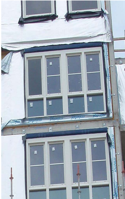
Figur 7 Överlappning av utvärdig duk
