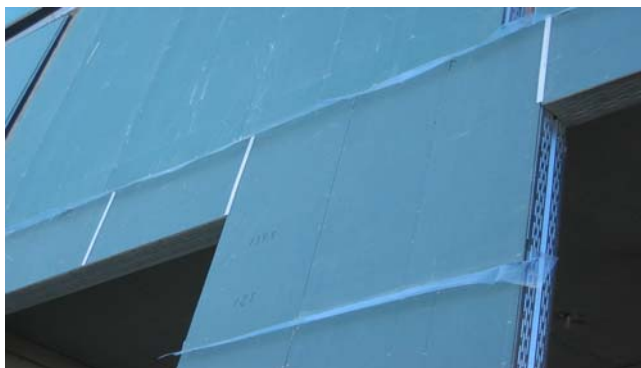
Figur 13. För att undvika att vatten kommer in har plastfolieringsor monterats i skarvarna mellan utegips-slivorna för att leda bort regnvatten som rinner på fasaden.
