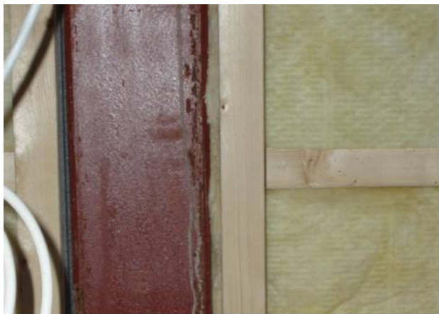
Figur 5. Tätning med isolering mot stål Stolpe
