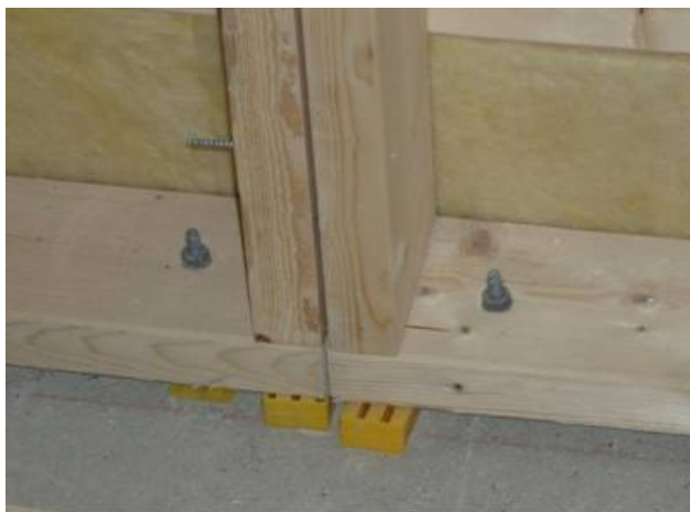
Figur 4. Infästning av utfackningsparti med bultar
