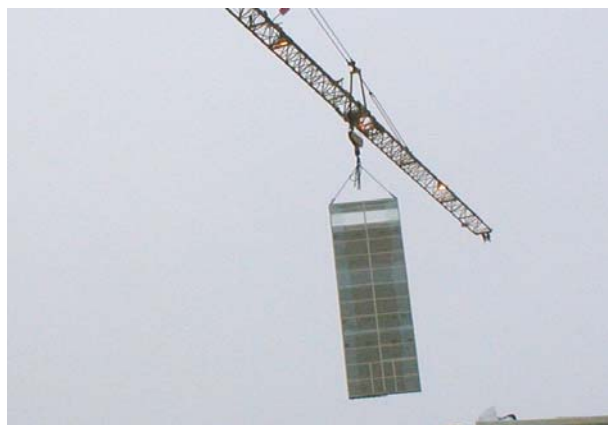
Figur 7. Lyft av planelement för montage i stommen.
