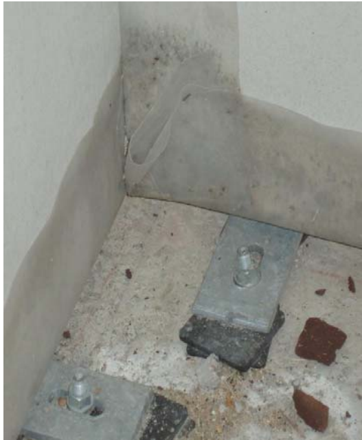
Figur 4 Infästning av utfackningsvägg mot golv
