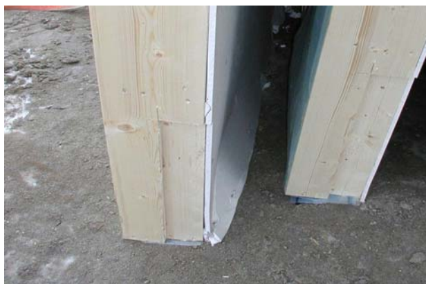
Figur 6. Projekteringsfel eller transportskada?
