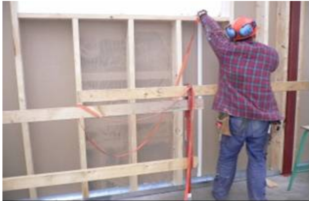
Figur 11 Montage av ett smutsigt utfacknings-element. Träreglarna hade vid montage redan synlig påväxt
