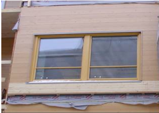
Figur 8. Prefabricerat väggelement med temporärt fastsatta kompletteringar
