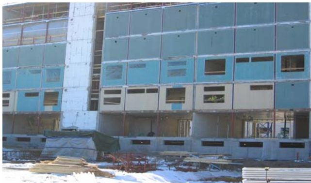
Figur 12. Utfackningselement monterade i stomme av stål och betong. Öppningar för fönster tas upp efter hand.
