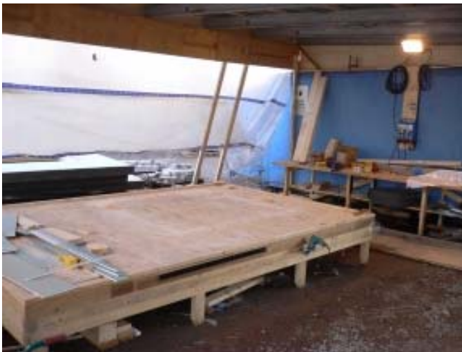
Figur 11. Utfackningselement byggs ihop i ene fältfabrik.
